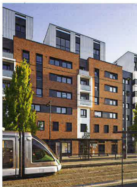
Les résultats des promoteurs du réseau Procivis atteignent leurs meilleures performances depuis 2010. Ici, Le Sirius à Strasbourg dans le quartier Neudorf-Etolle, réalisé par Pierres & Territoires de France-Alsace. Arch. La Como. ©A. Häfner
